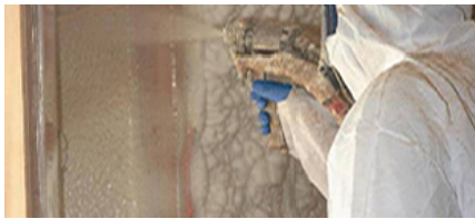
Aplicación de rociado de SPF en la pared
